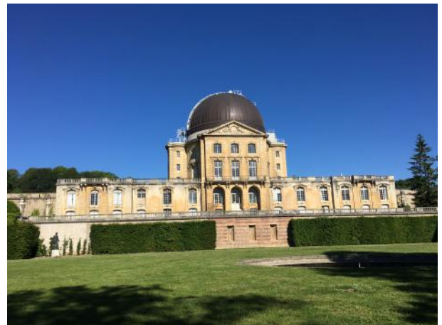
Figure 1 – La façade de l'observatoire, à Meudon (Photo : E.Foucher)
